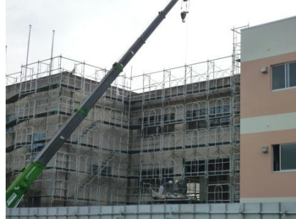
校舎耐震化工事Ⅱ期開始
