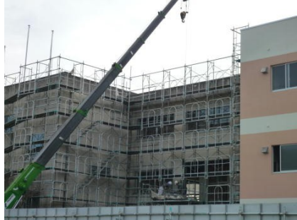
校舎耐震化工事Ⅱ期開始
